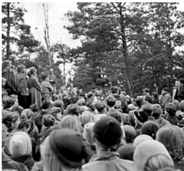
Första spadtaget på gymnasiebyggnaden tas och rektor David Thörnblom talar. Året är 1954.
